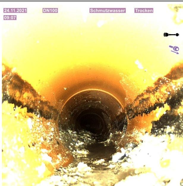
A1 Ablagerungen, hartes oder verdichtetes Material, 10 %, 5-8 Uhr
