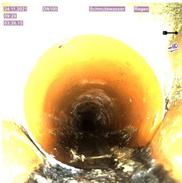
A1 Ablagerungen, hartes oder verdichtetes Material, 10 %, 4-8 Uhr, Beginn Streckenfeststellung
